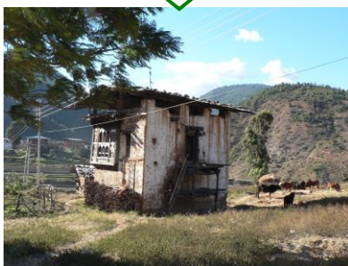
เกิดบ้านและยังข้าว เพื่อการพักอาศัยและเก็บผลผลิตจากการเกษตร ที่สร้างจากดินและไม้ มีความสอดคล้องกับที่ตั้ง แต่ไม่ถือเป็นพื้นที่ศักดิ์สิทธิ์
